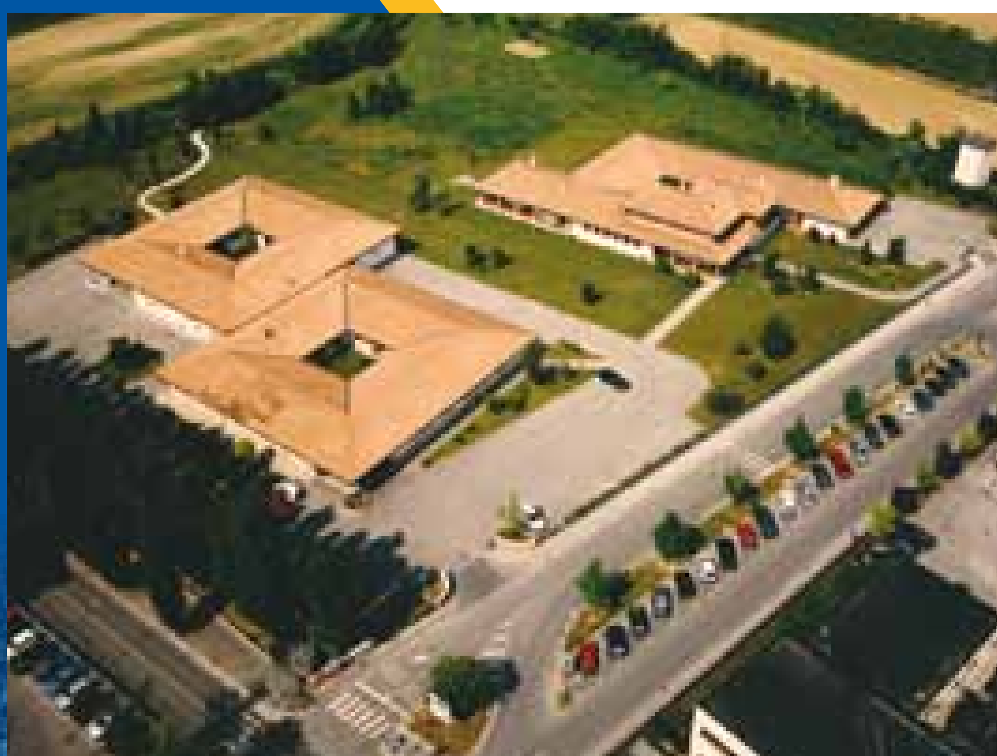
Veduta dall'alto dell'intero complesso di Oderzo
