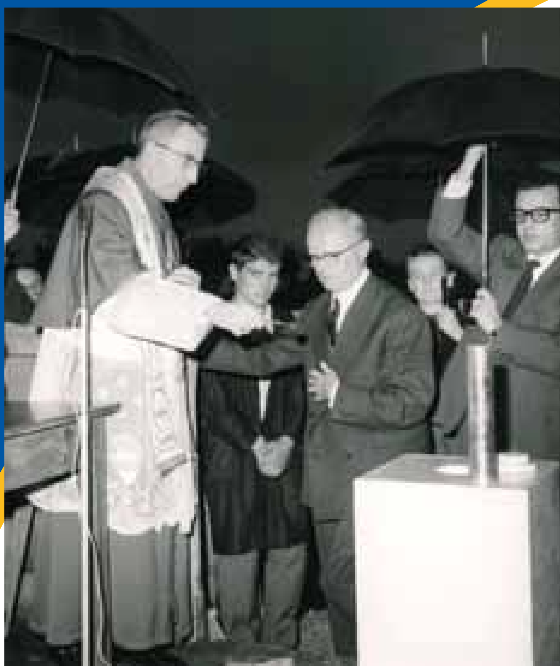
Mons. Albino Luciani durante il rito di posa della prima pietra. Nella colata di cemento iniziale è stato deposto il cilindro con dentro, a ricordo dell'evento, la pergamena benedetta dal Vescovo
